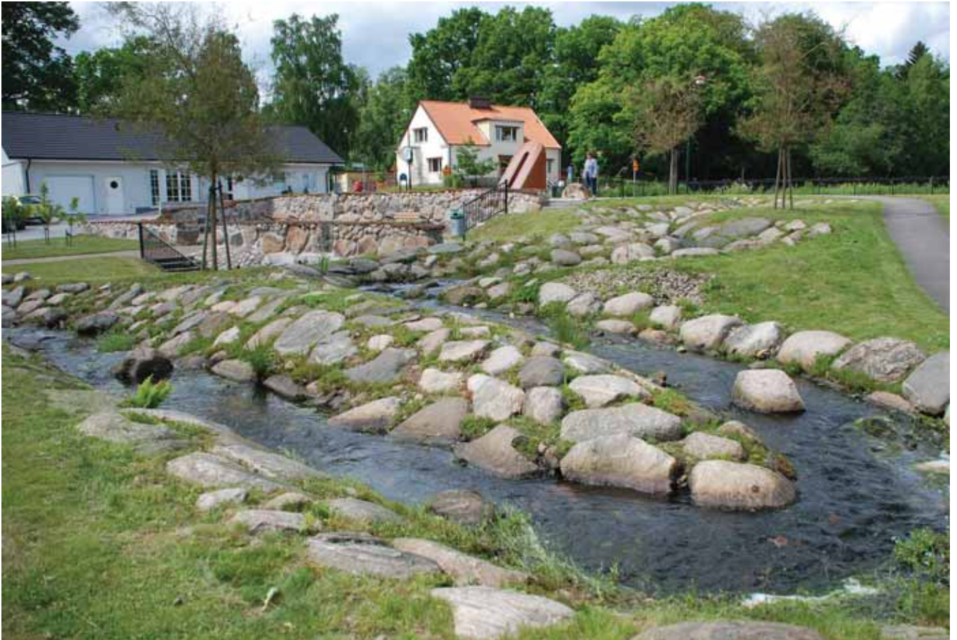
Den vackert anlagda, slingrande fiskvägen ansluter Brännemölladammen (Ankdammen) med Hörsån nedströms. I bakgrunden Mittelen.
